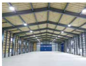
田村木材工業(株)倉庫新築工事
