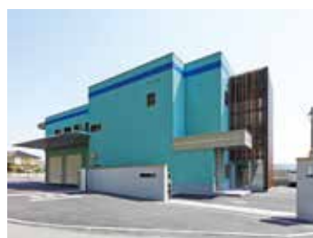
中野酸工(株)広島事業所新築工事
